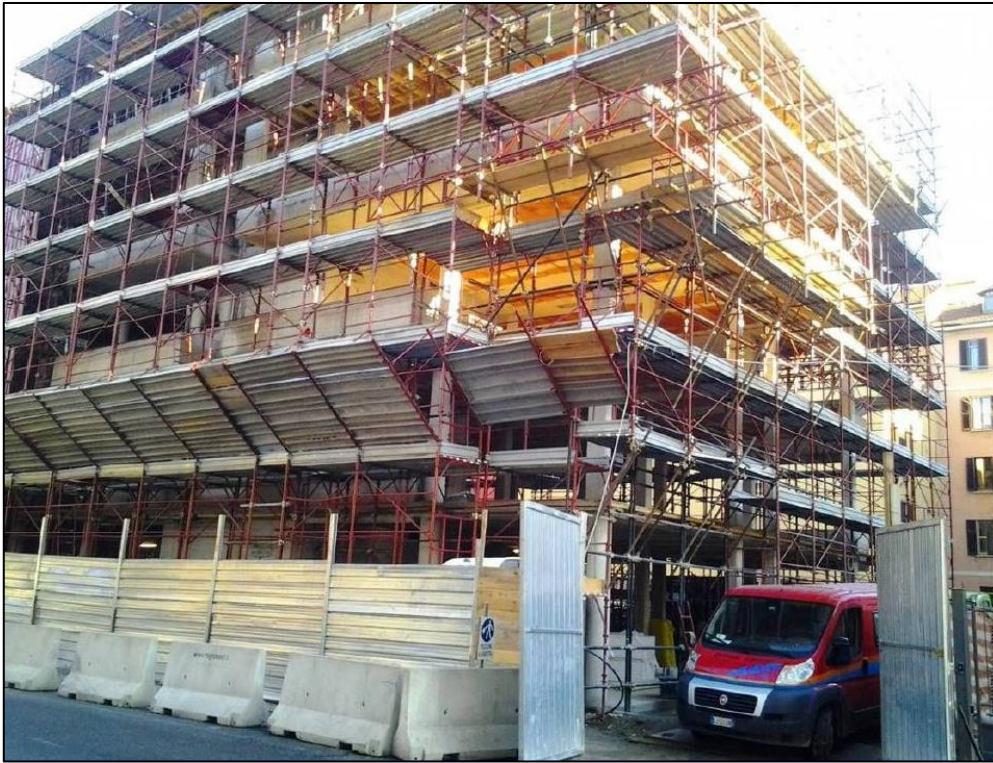
Figura 5.18: Cantiere edificio via Alberto Mario
