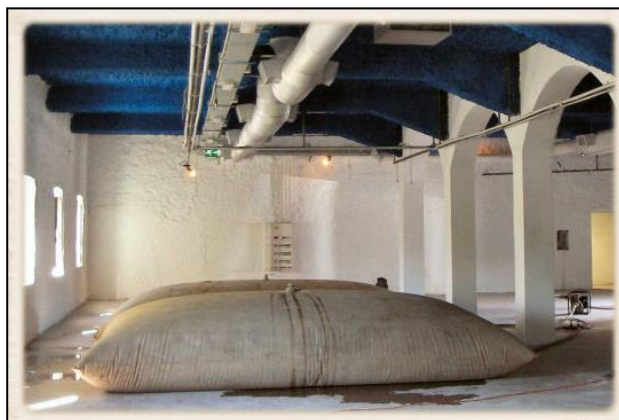
Figura 5.4: Prova di carico su solai con n. 2 serbatoi piani
