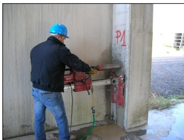
Figura 4.36: Esecuzione di un carotaggio
