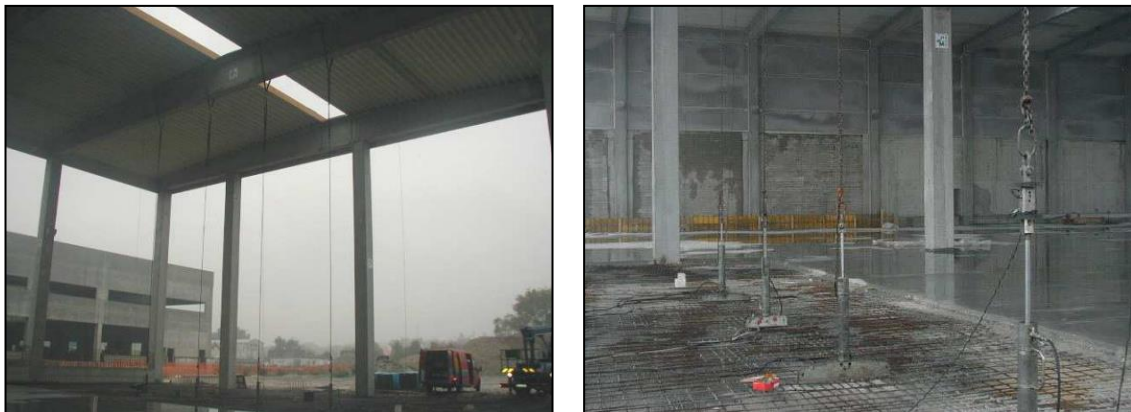
Figura 5.9: Fase di allestimento e ancoraggio inferiore con tasselli meccanici
