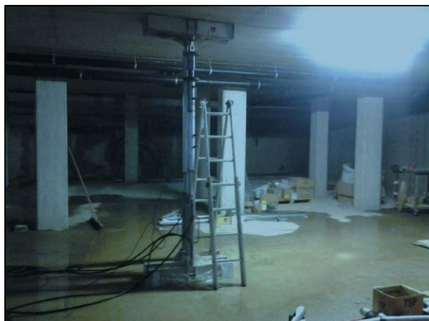
Figura 5.19: Particolare martinetti di carico
