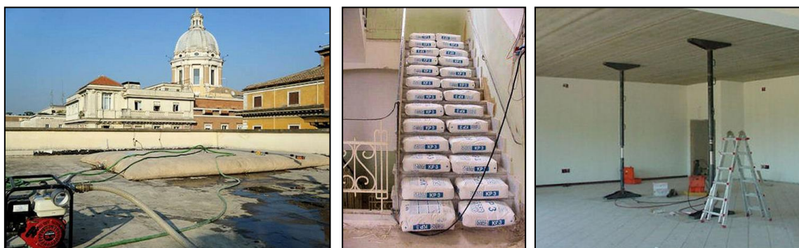
Figura 5.2: Prove di carico su copertura, scale e solaio con carichi distribuiti e concentrati
