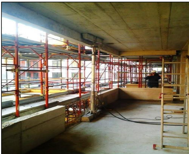
Figura 5.36: Particolare martinetti di carico
