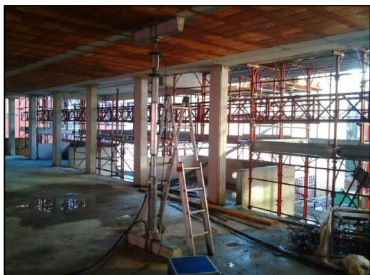
Figura 5.27: Particolare martinetti di carico
