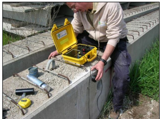
Figura 4.30 – esecuzione di un'indagine ultrasonica su una trave
