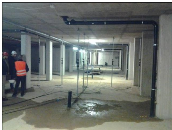
Figura 5.20: Particolare sensori differenziali
